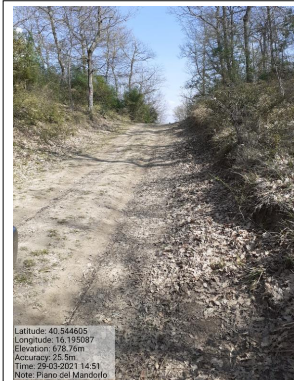
Int.3.1.1 Manutenzione di Strada forestale di Servizio Foto 7
